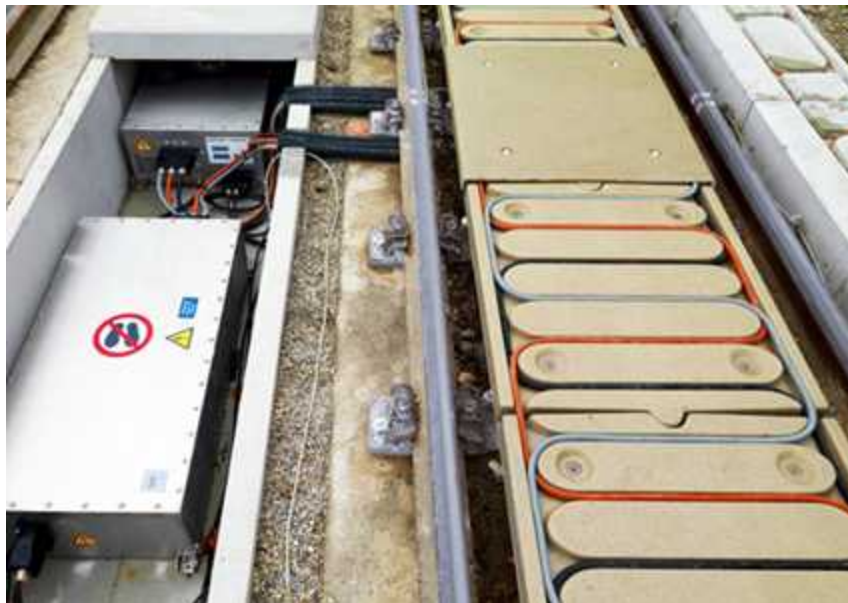
[그림 2-24] Primove 2차 모델의 Augsburg에 설치된 삼상 급전라인 및 인버터
