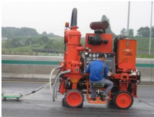
<그림 2-9> 그루빙 머신(좌) 및 노면그루빙 작업 전경(우)
