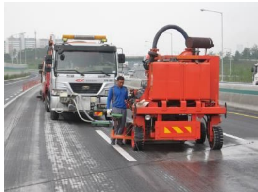
<그림 2-9> 그루빙 머신(좌) 및 노면그루빙 작업 전경(우)
