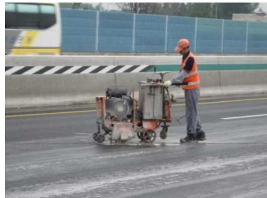
<그림 2-10> 배수홈 절삭기(좌) 및 배수홈 절삭 작업 전경(우)
