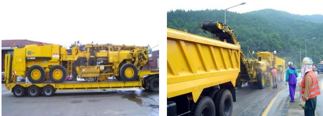
<그림 2-8> 노면절삭기(좌) 및 노면절삭 작업 전경(우)
