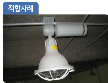
[위험물저장소 방폭형 등기구 설치]
